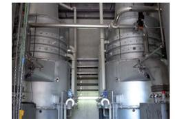
Die Umsetzung geschieht im ersten Schritt über zwei konventionelle Festbettvergaser mit entsprechender Gasnachbehandlung über Gastrockner, Gaswäsche und Gaskühler in konventioneller Technik nach Industriestandard. Zur Stromerzeugung werden zwei BHKW's eingesetzt, mit entsprechender Leistung und entsprechender Anpassung an die Gasqualitäten.
